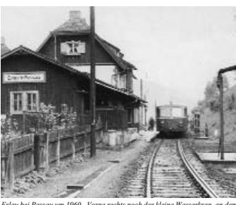
Erlau bei Passau um 1960. Vorne rechts noch der kleine Wasserkran, an dem die Dampfloks ihre Wasservorräte ergänzten. (Foto: Gerd Wolff)
